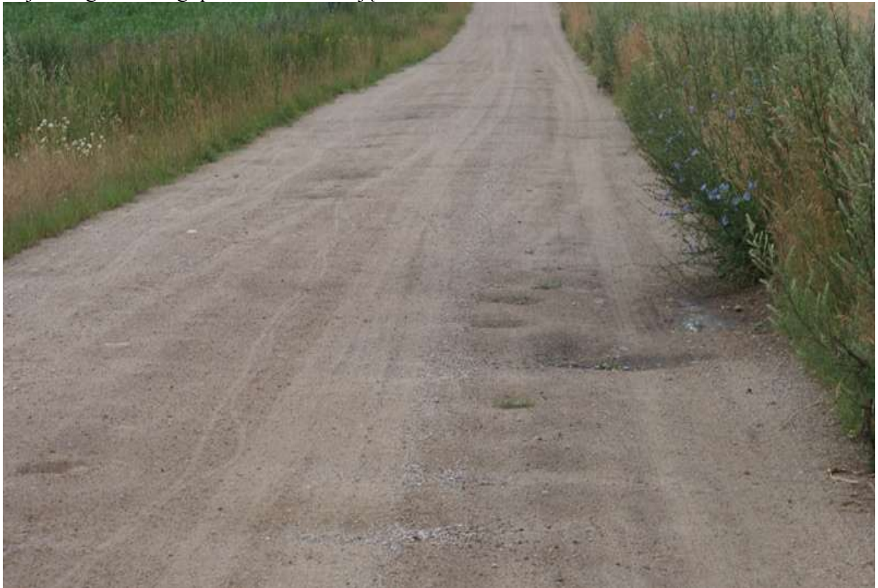
Zdj.3 Fragment drogi przed modernizacją
