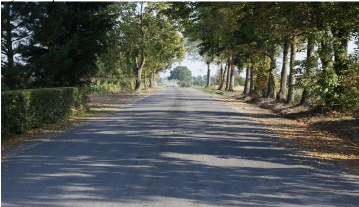
Zdj. 4 Nowo powstała nawierzchnia
